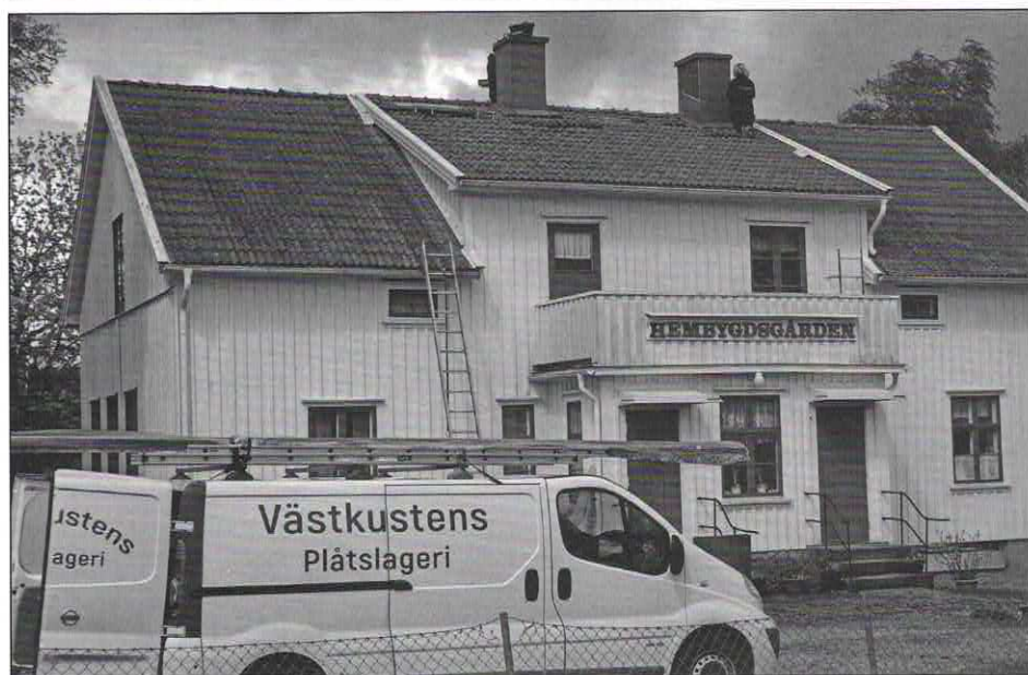
Underhållsarbete på Hembygdsgården våren 2022.
